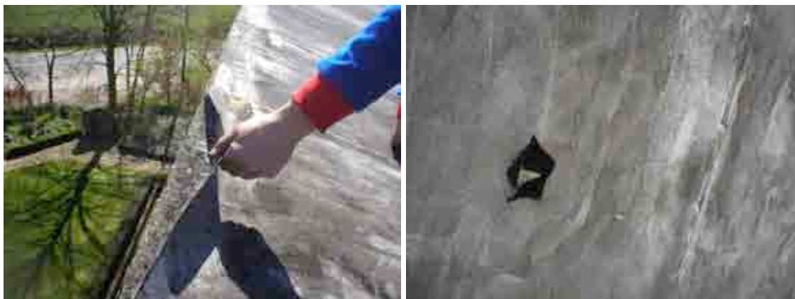
afb. 3.1 en afb. 3.2 bron © architectuurstudio de schacht & partner(s) bv ovv bvba INSPECTIE DAK d.d. 4 april 2007
