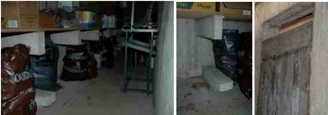
afb. 3.53, afb. 3.54, afb. 3.55, afb. 3.56 en afb. 3.57
